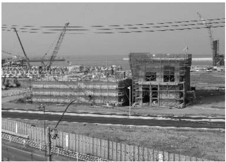
二町谷の污水处理施設(建設工事中)
