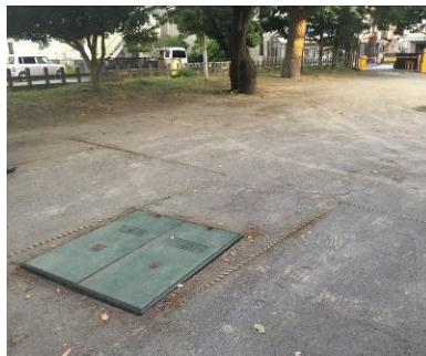
耐震性貯水槽点検口(北側)
