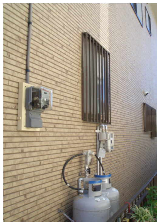
外壁 リフォーム後
