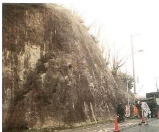
〔ポイント3〕 道路の露頭 現在の露頭は崩れやすいのでコンクリートを 吹き付けられて露頭は見えません (現在)。
