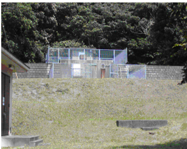
どうはいすい ずい道配水池
