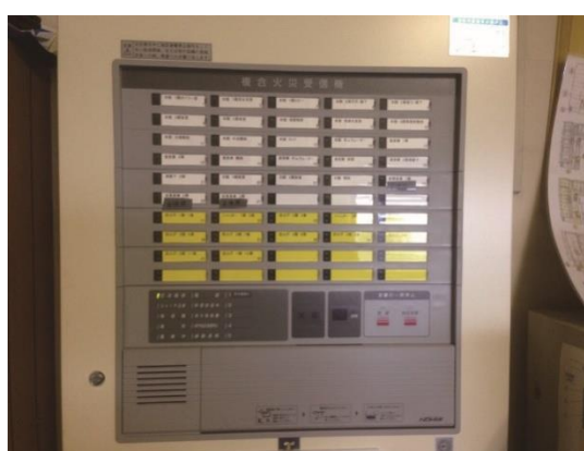
じどうかさいほうちせつび 自動火災報知設備（写真提供 消防署）
