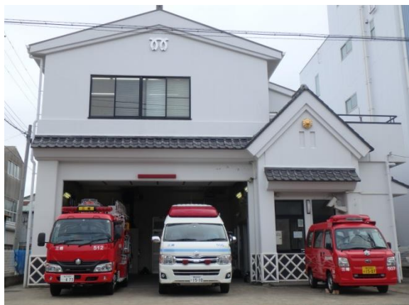
みさきしゅつちようじよ 三崎出張所 (写真提供 横須賀市消防局)
