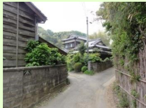
鎧下見板の外壁など（上宮田）
