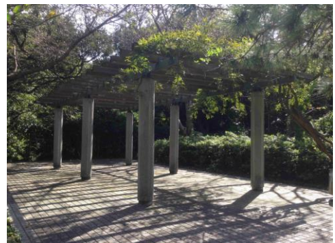
公園内の休憩施設（パーゴラ）
