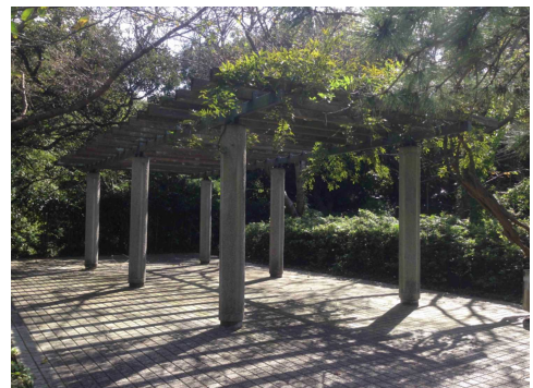
公園内の休憩施設（パーゴラ）
