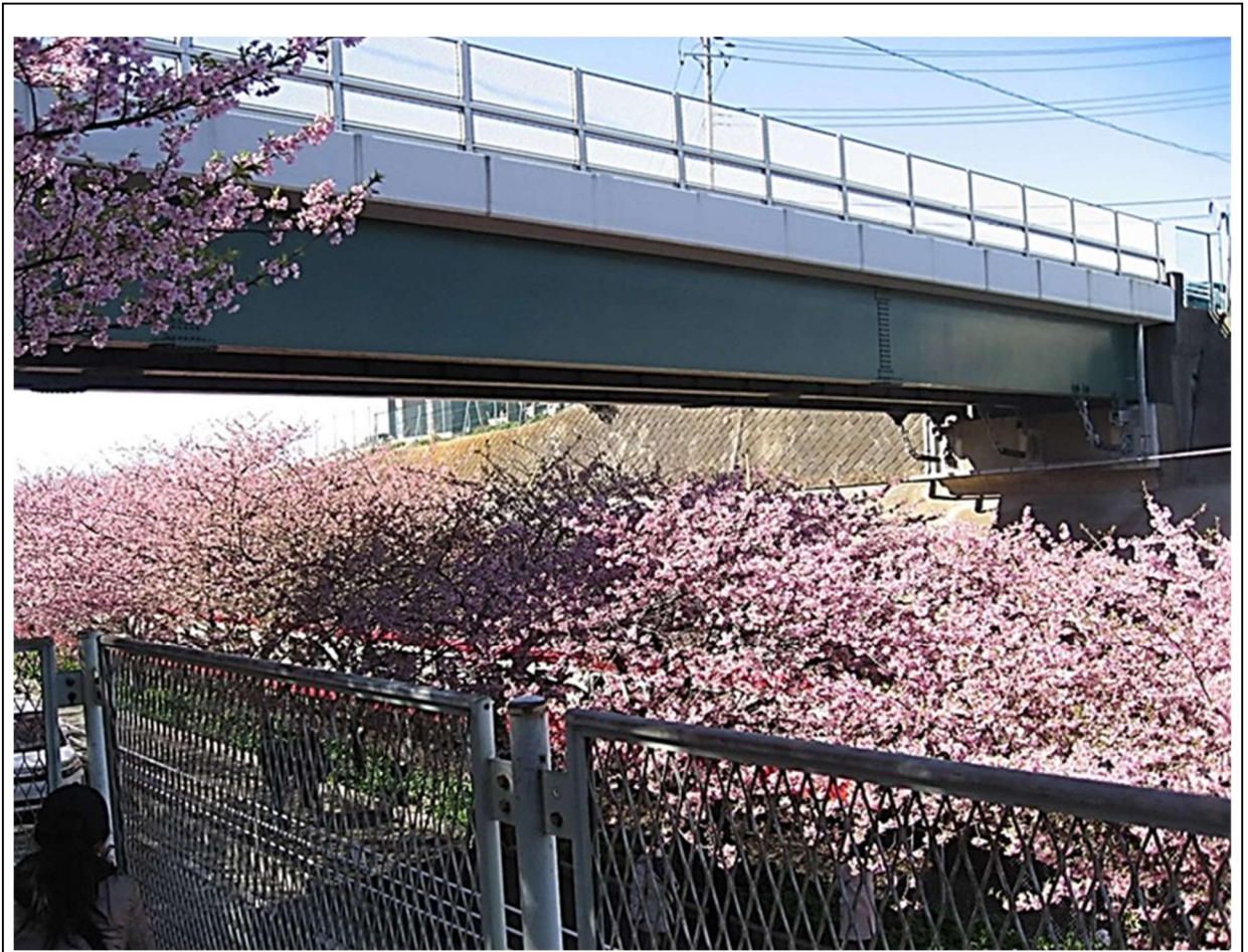
山ヶ谷戸跨線橋
