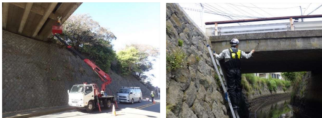
写真6-1 橋りょう点検状況
