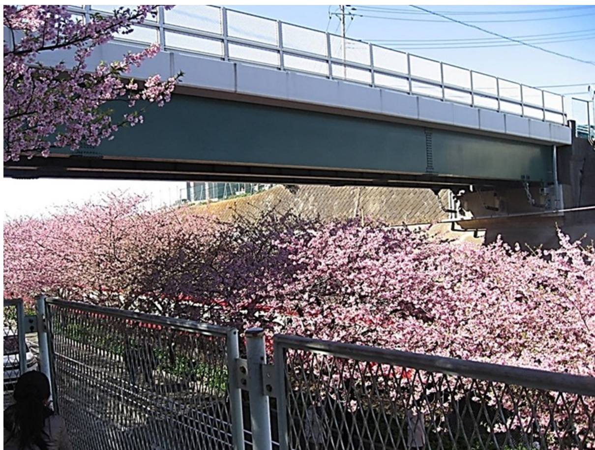
山ヶ谷戸跨線橋
