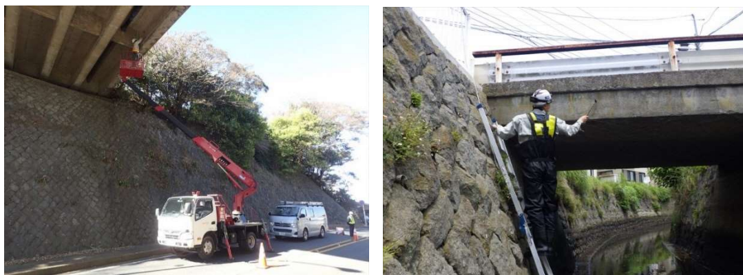
写真 6－1 橋りょう点検状況
