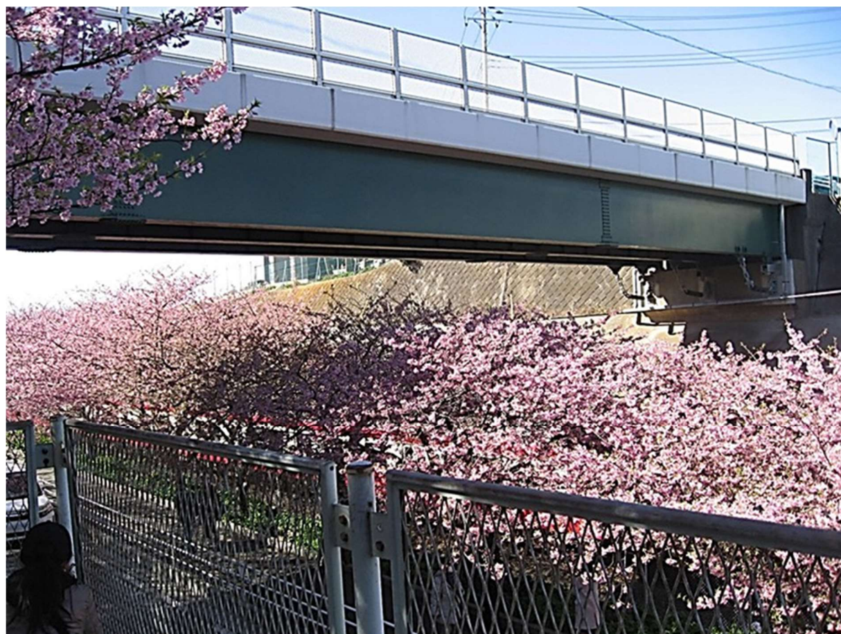
山ヶ谷戸跨線橋
