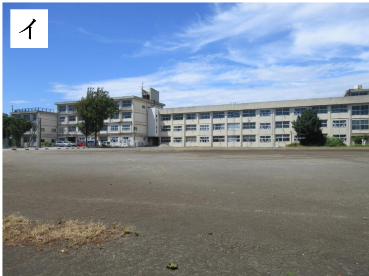
旧三崎中学校校舎(一部市役所庁舎として使用)
