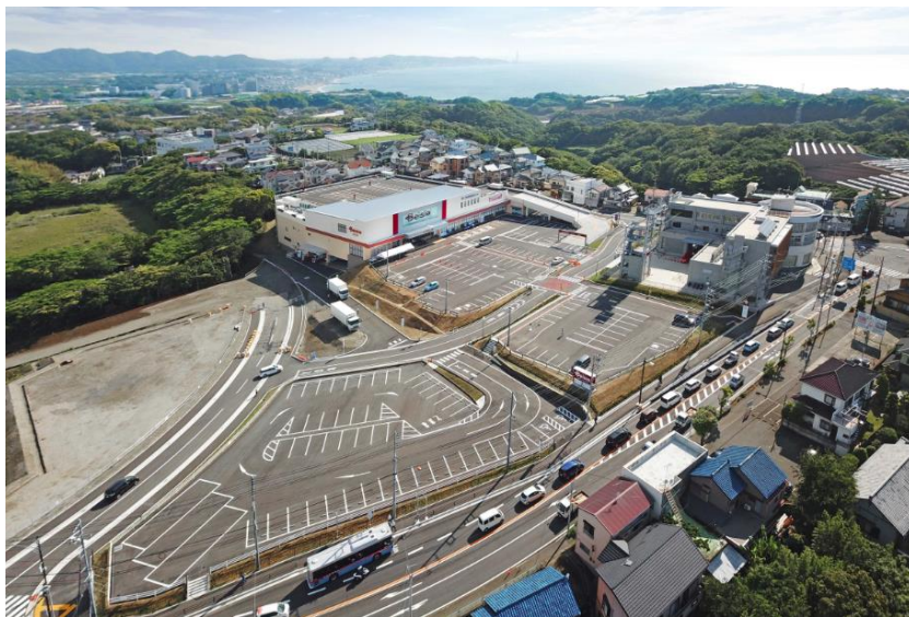
国道(三崎口方面)上空から見た三高跡地
