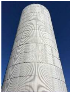
小網代配水塔外観
