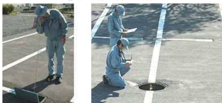
水道管の漏水調査の様子
