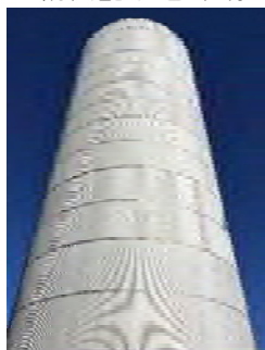
小網代配水塔外観
