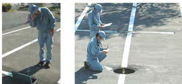
水道管の漏水調査の様子
