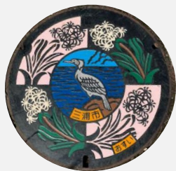
カラーマンホール (南下浦中学校前)
