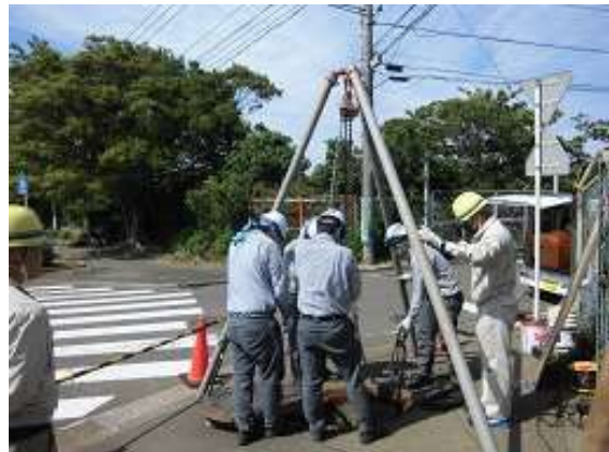
管路の保守点検作業 2
