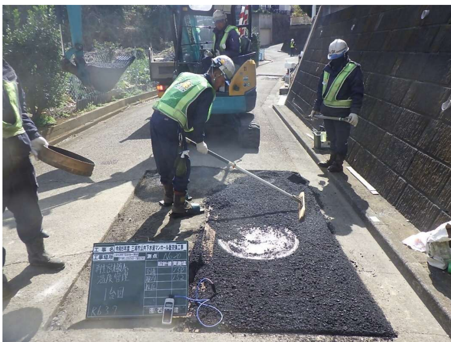
三浦市公共下水道マンホール蓋交換工事
