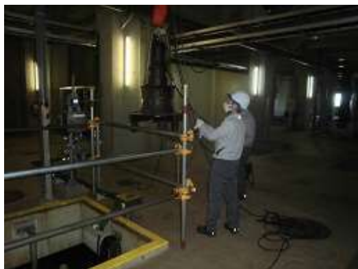
処理場保守点検作業
