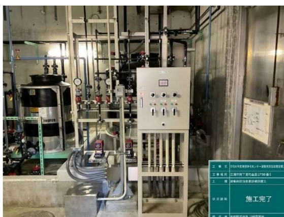
令和6年度 東部浄化センター凝集剤添加装置設置工事
