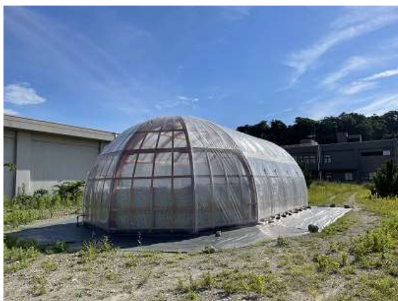
高付加価値作物の生産技術の確立のための ビニールハウス（令和5年度）
