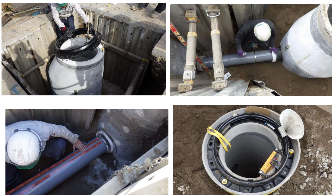
令和７年度上宮田岩井口地区枝線管きょ増築工事 令和７年度下宮田馬場地区枝線管きょ増築工事
