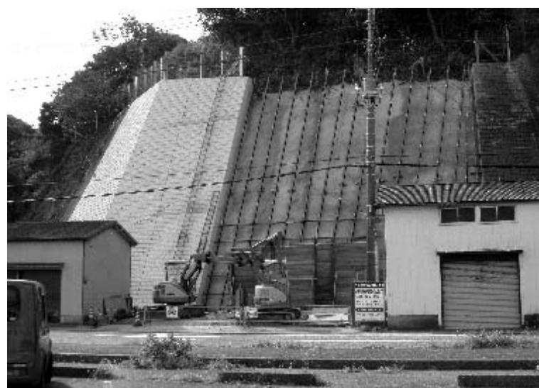
急傾斜地崩壊対策工事 (城ヶ島地区)
