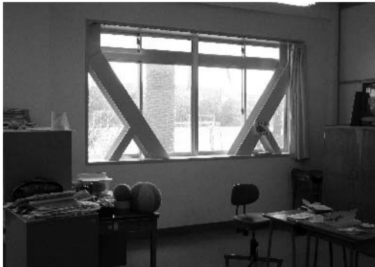
耐震補強工事が行われた教室（初声小学校）
