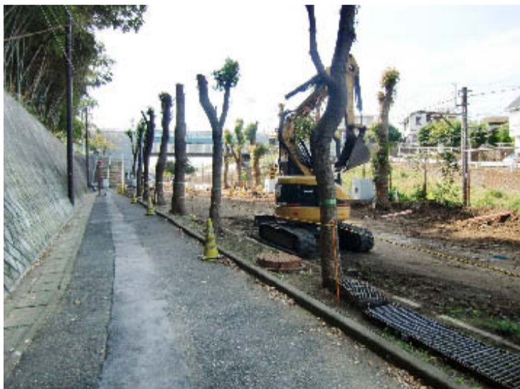
整備工事中の市道310-3
