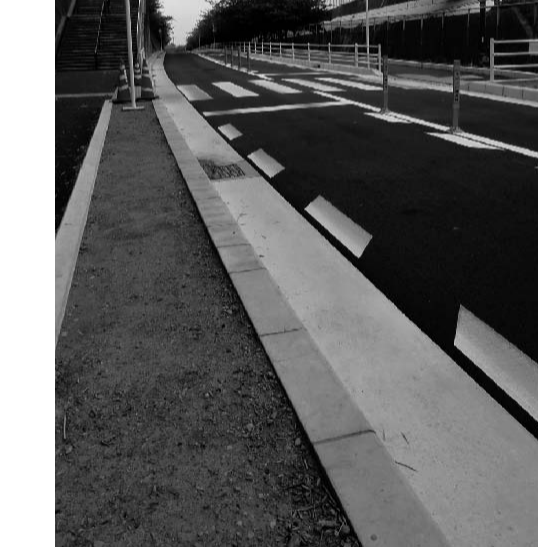
開通した市道310-3号線
