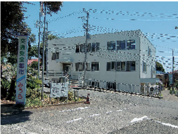
災害対策本部が設置された市役所分館
