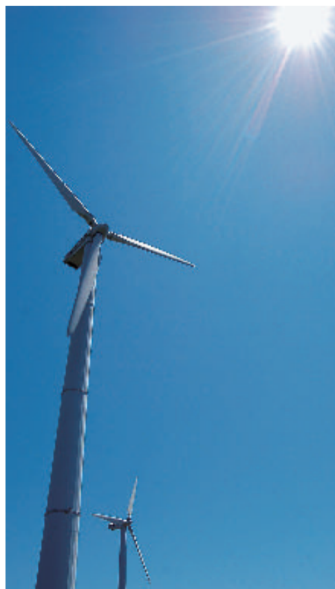
風力発電 (宮川公園)
