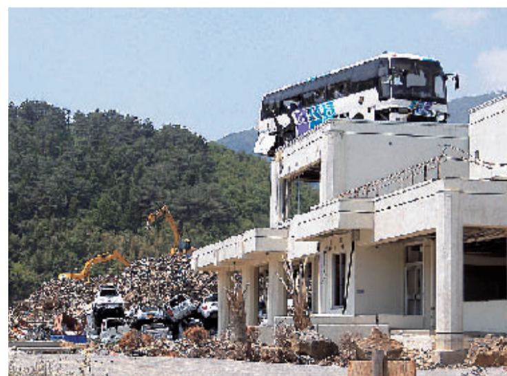
東日本大震災の被災地 (宮城県石巻市)
