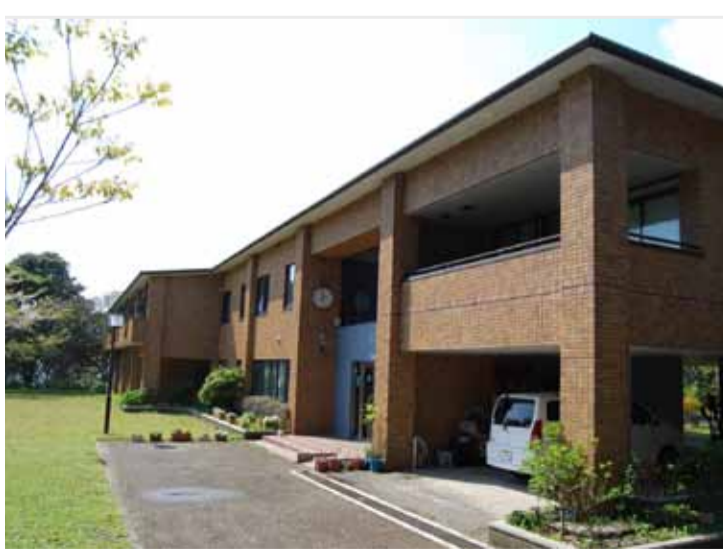
東京大学臨海実験所 (新実験研究棟)
