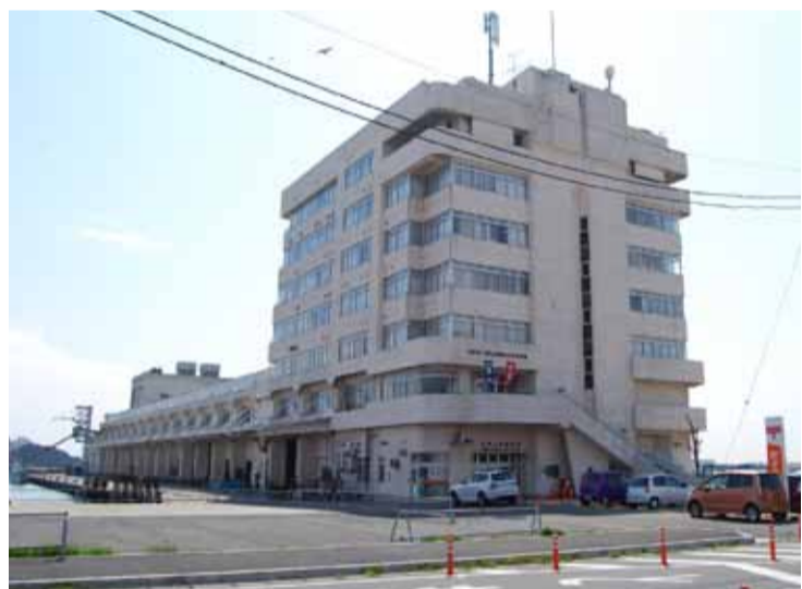
三崎水産物地方卸売市場
