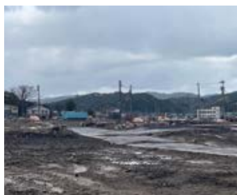
被災した輪島朝市
