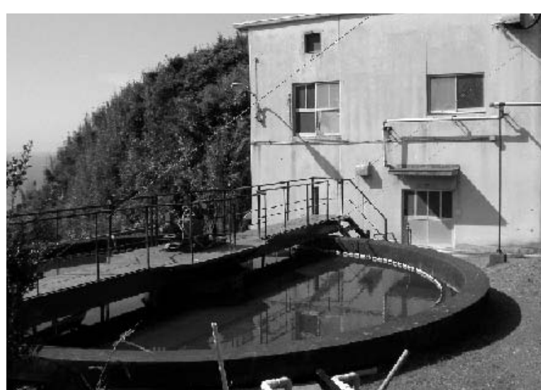
市のし尿処理施設(衛生センター)
