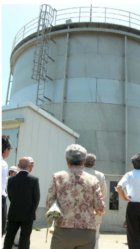
松輪配水池を視察
