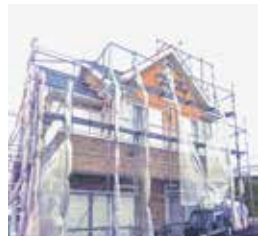
リフォーム助成金を受け工事中
