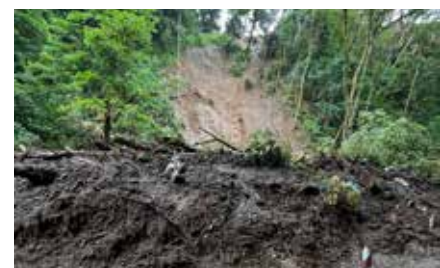
飯盛地区の災害現場
