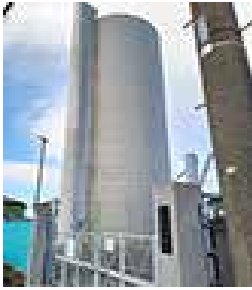
小網代配水塔
