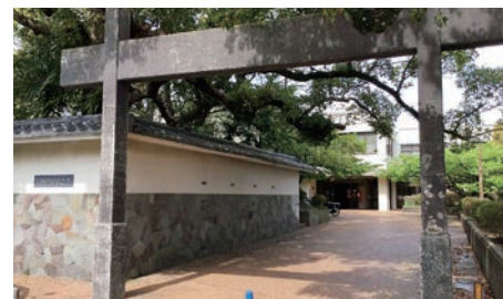
建て替えられる南下浦市民センター
