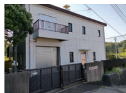
金田中継センター(汚水を処理場へ送るポンプ場)
