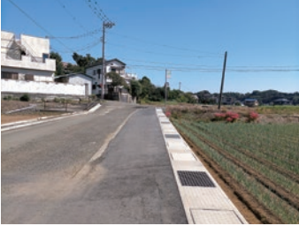
整備された市道1885号
