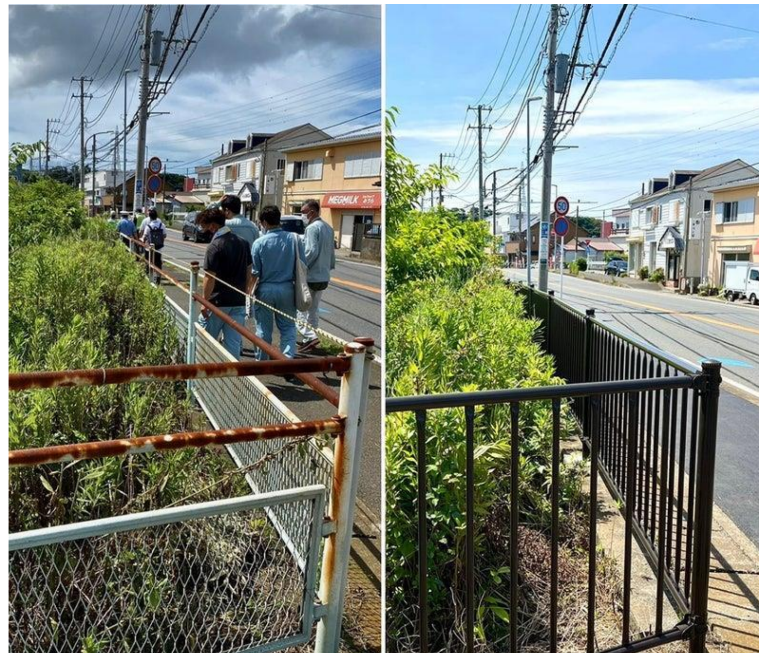
錆びた柵の補修
