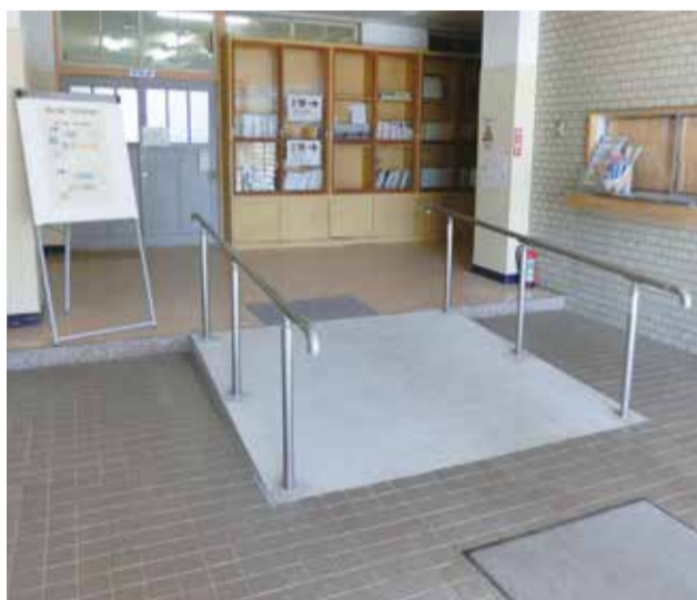
市役所第2分館に設置されたスロープ
