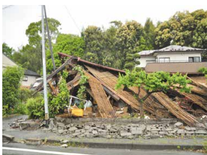
熊本地震で倒壊した家屋
