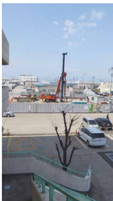
市場横に建設工事中の低温卸売場
