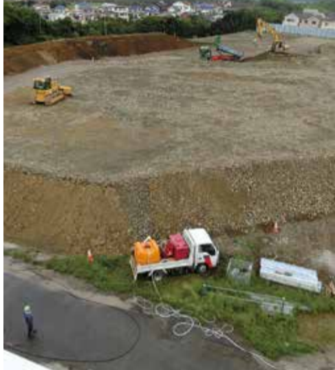
工事中の三崎高校跡地
