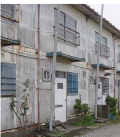
下宮田の市営住宅
