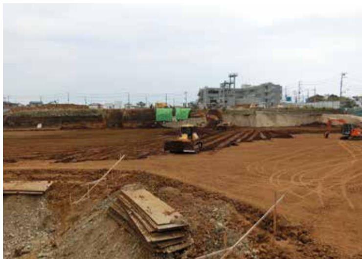
三崎高校跡地の盛り土造成工事
