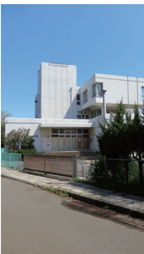
解体される旧青少年会館
