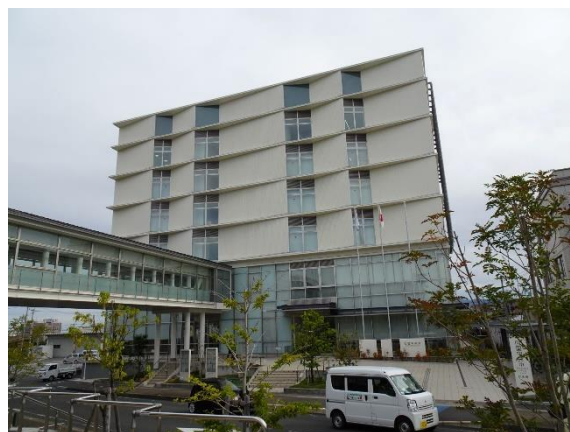
四国中央市役所 新庁舎
