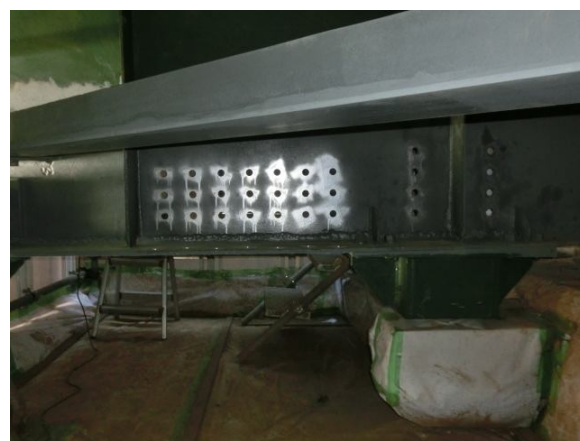
当て板補強（孔明け）
