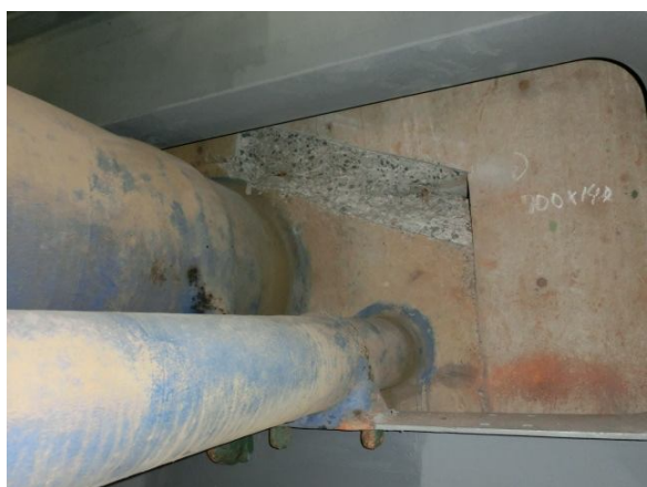
コンクリート補修箇所
