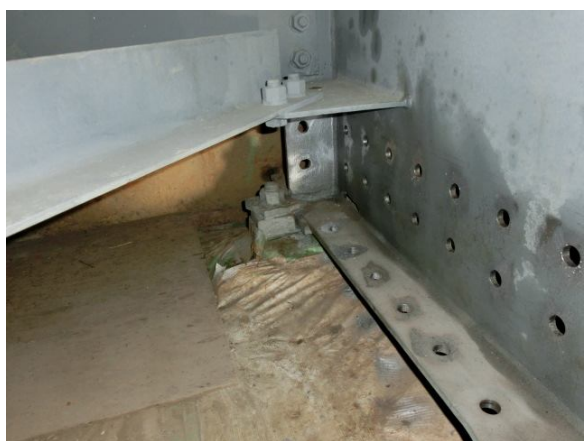
当て板補強（孔明け）
