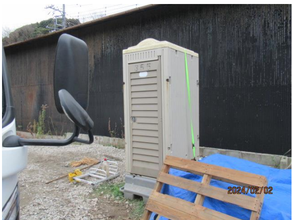
現場監査 トイレ設置
