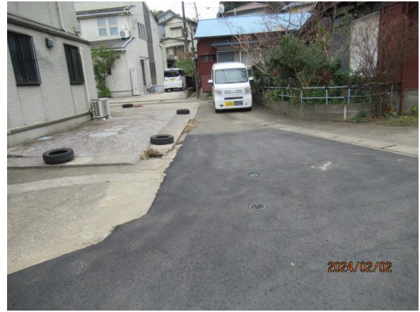
現場監査 アスファルト舗装 風景
