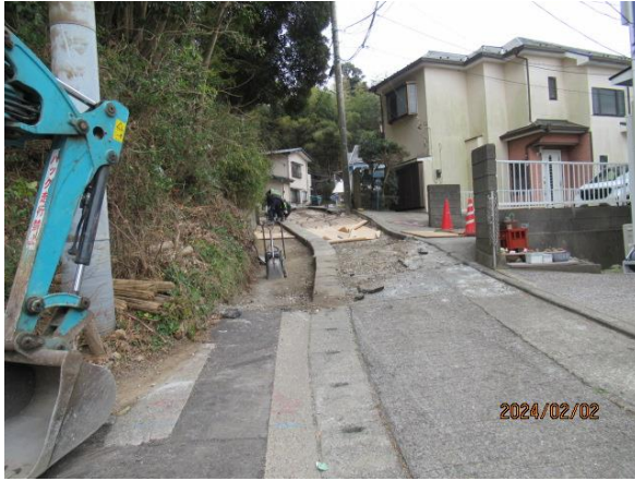
現場監査 コンクリート舗装 風景
