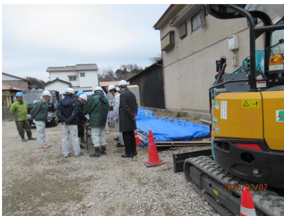
現場 安全書類関係 監査風景
