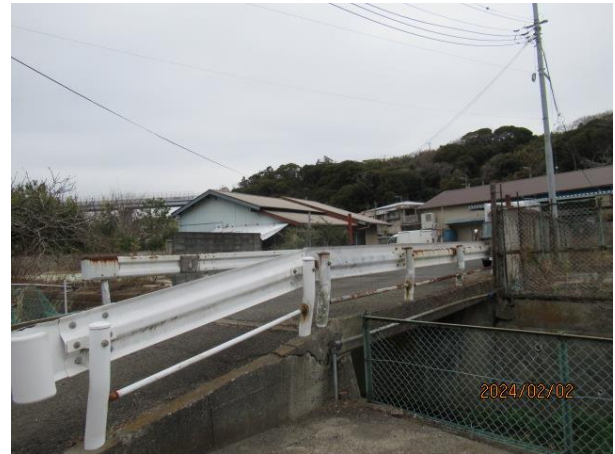
現場監査 水路上 占有許可 私有道路
