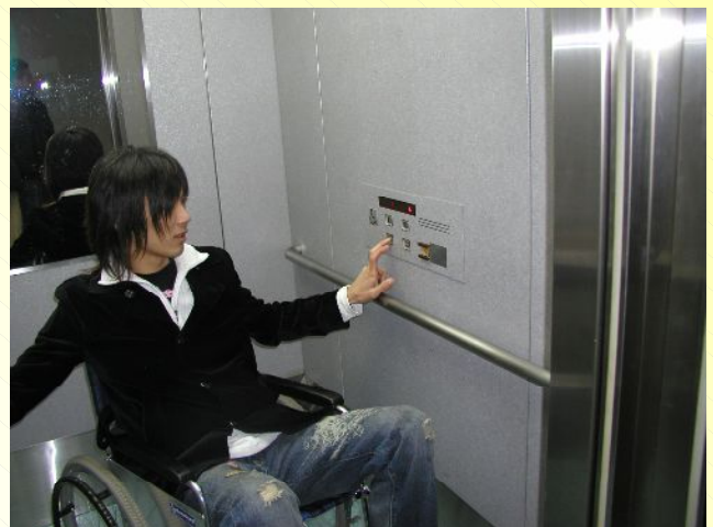
エレベーター内部操作盤
