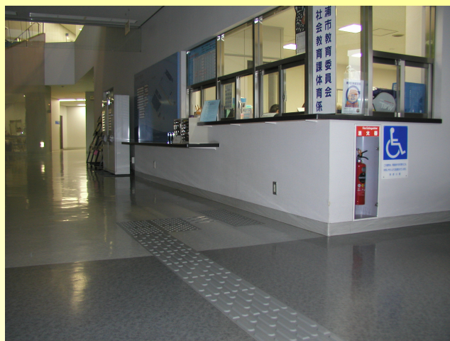
受付への点字ブロック
