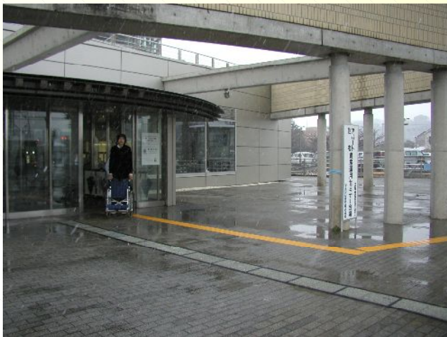
入口付近点字ブロック
