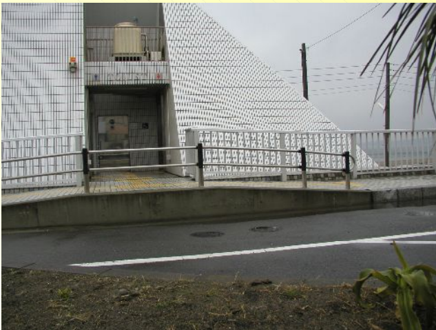
トイレ前スロープ
