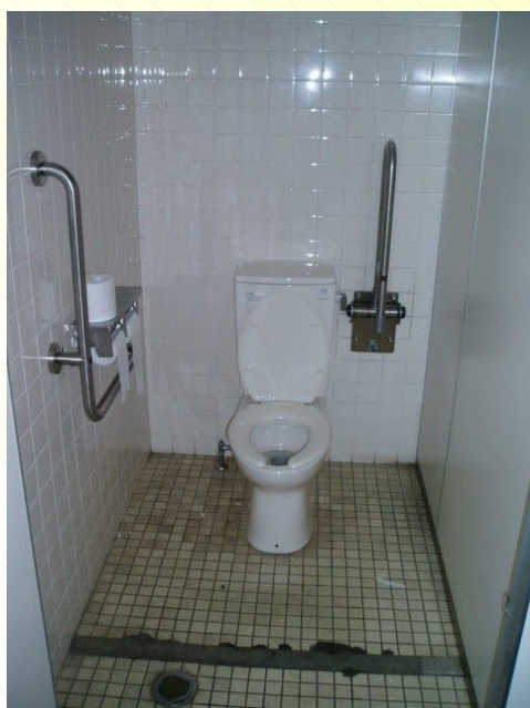
女性用トイレ手すり
