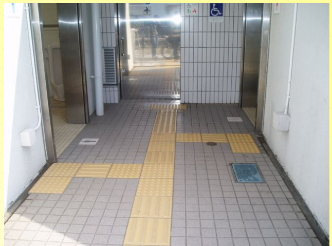
トイレ入口（点字ブロック）
