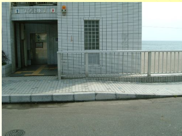
トイレ前スロープ
