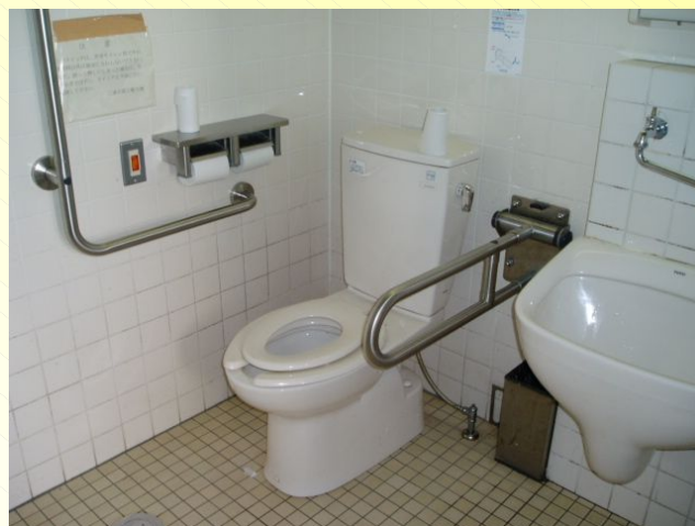
多目的トイレ内部（子供用便座）
