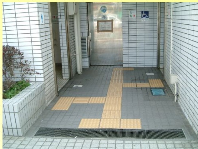
トイレ入口（点字ブロック）
