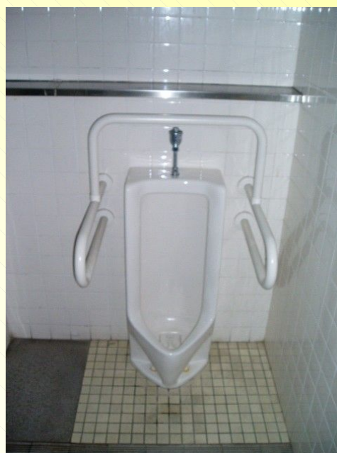
男性用トイレ手すり
