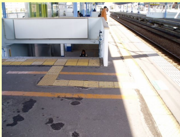
階段からの点字ブロック設置状況
