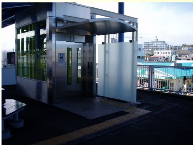
エレベーターからの点字ブロック設置状況
