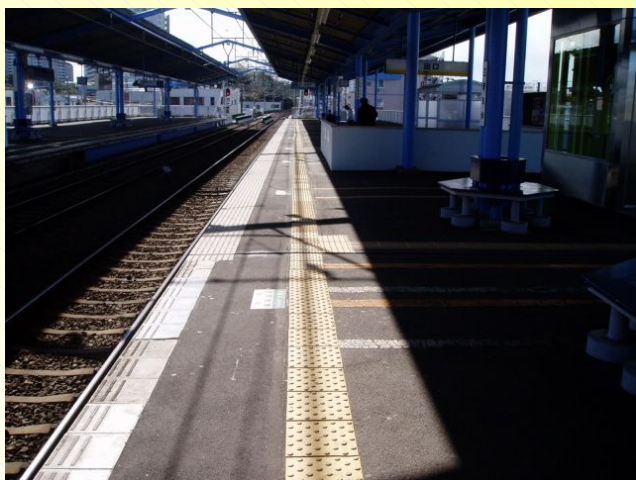
ホーム点字ブロック設置状況
